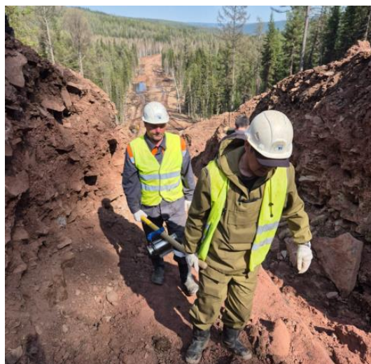
Рис. 1. Транспортировка гамма-дефектоскопа к месту проведения работ [Fig. 1. Transportation of the gamma flaw detector to the work site]
