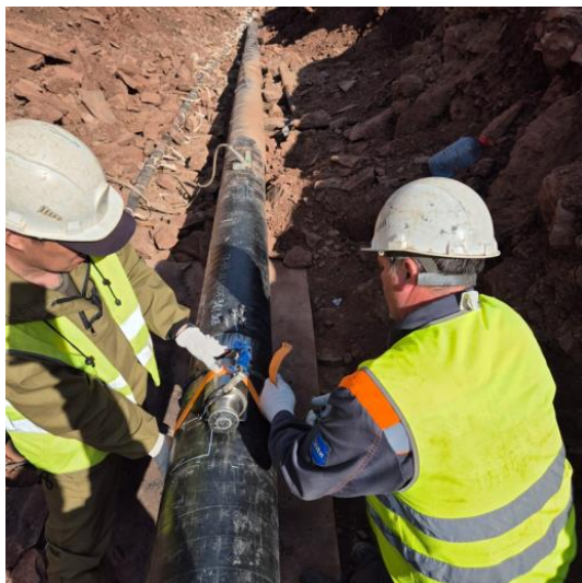
Рис. 2. Подготовка гамма-дефектоскопа к работе [Fig.2. Preparing the gamma flaw detector for operation]
