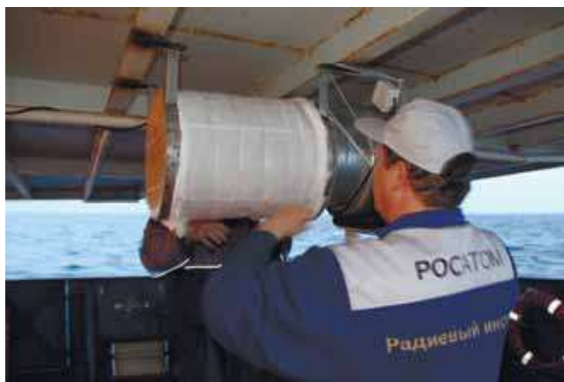
Рис. 10. Замена фильтра на фильтровоздушной установке. Работы выполняют В. Осокин и А. Сергеев. Фото И. Ермаченкова
