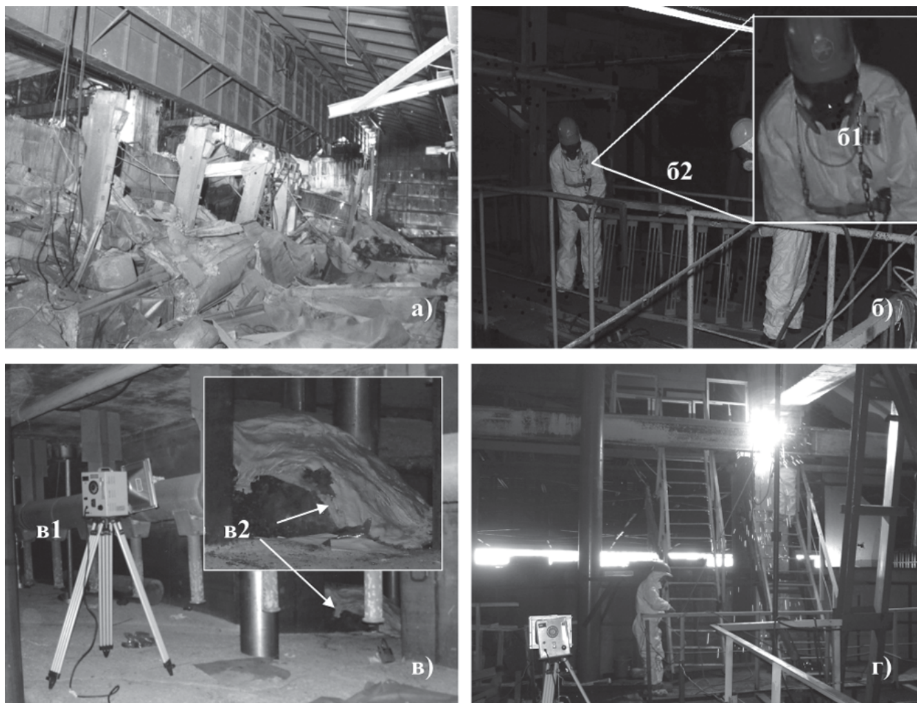
Рис. 2. Условия работ внутри Объекта «Укрытие»:
