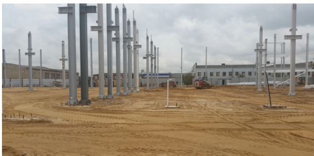
Рис. 3. Строительство объекта после изъятия РАО и ОНАО и проведения заключительного комплексного радиационного обследования территории
