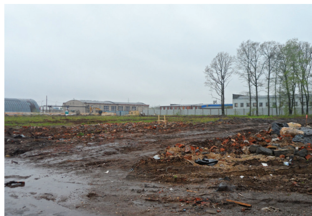
Рис. 1. Земельный участок до начала проведения вскрышных работ, 2017 г.
