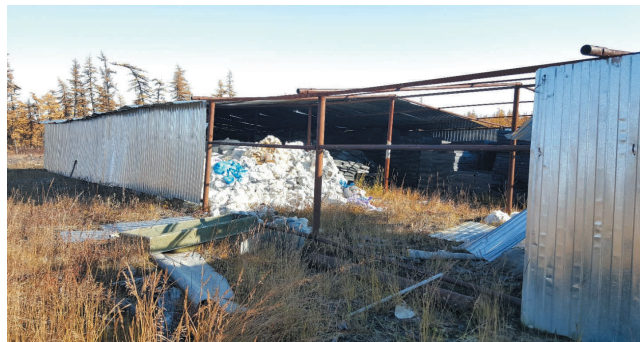
Рис. 2. Вид на заброшенное кернохранилище [Fig. 2. View of the abandoned core storage]
