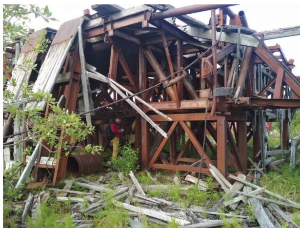
Рис. 1. Металлоконструкции над устьем боевой скважины на МЯВ «Агат» [Fig. 1. Metal structures above the mouth of the battle well on the PNE «Agat»]
