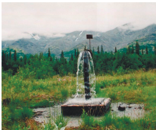
Fig. 7. Self-flowing borehole No. 45 [Рис. 7. Самоизливающаяся скважина № 45]
