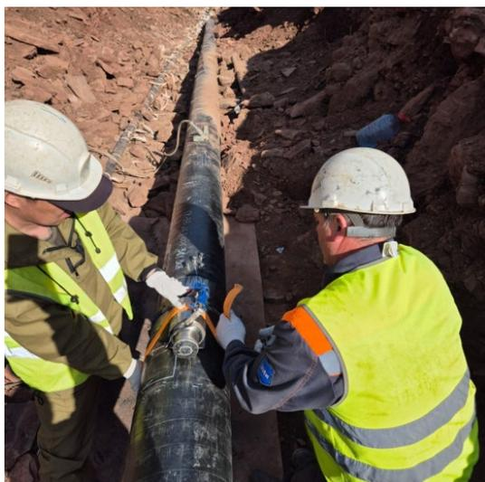
**Рис. 2.** Подготовка гамма-дефектоскопа к работе
